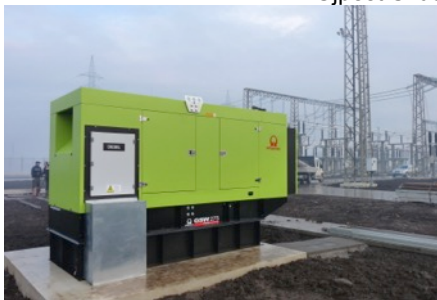
Mavír Hévíz 220 kVA
